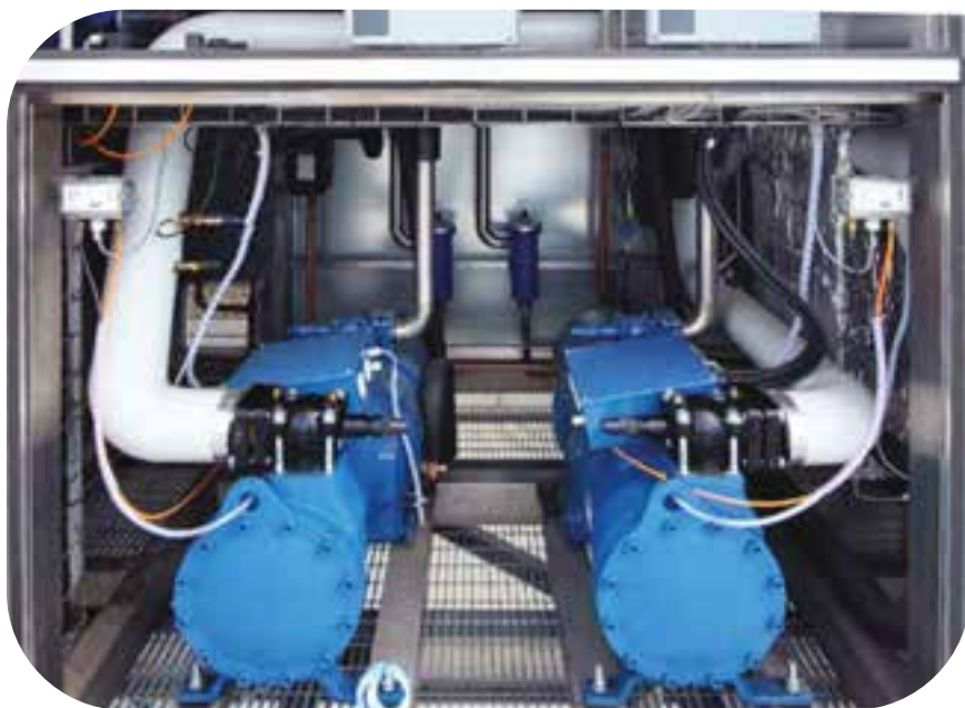
Installazione di compressori Frascold nell'innovativo chiller Soritronic
